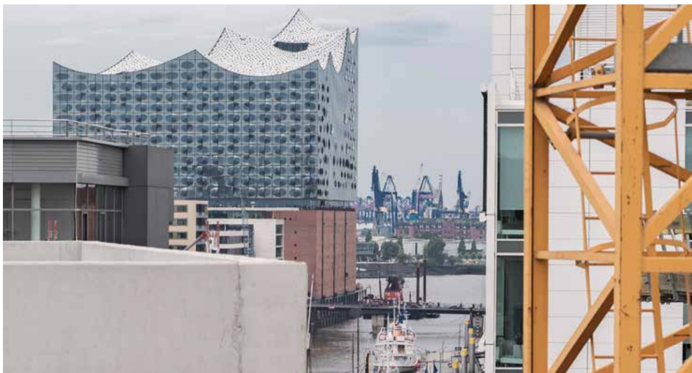
Baustelle mit Ausblick: „KPTN“ in der HafenCity
